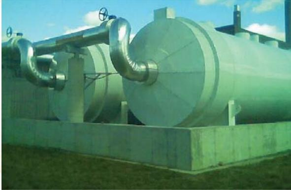
Stockage thermique par matériau à changement de phase (MCP) pour la production d'eau refroidie à l'usine d'IBM Canada à Bromont
